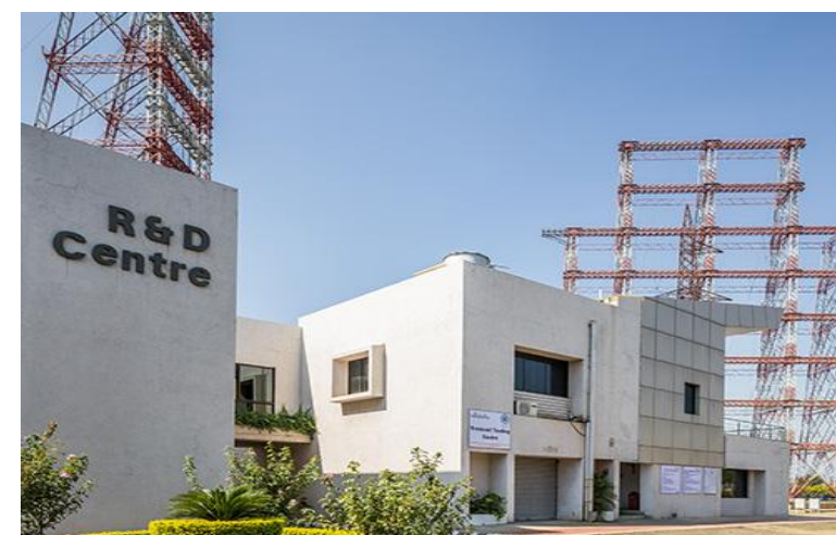
Installation d'essai de pylônes
