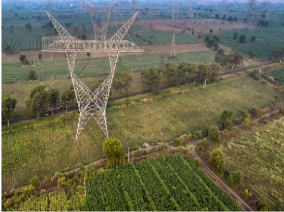
Ligne de transport Wardha Aurangabad de 1 200 kV
