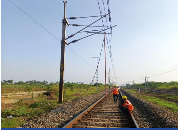
Projet ferroviaire Chennai-Gudur
